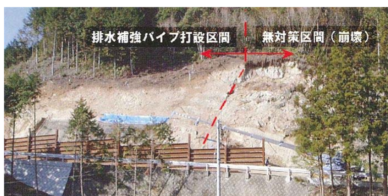
写真-2.3.2 切土法面に施工された排水補強パイプとその効果 35)
