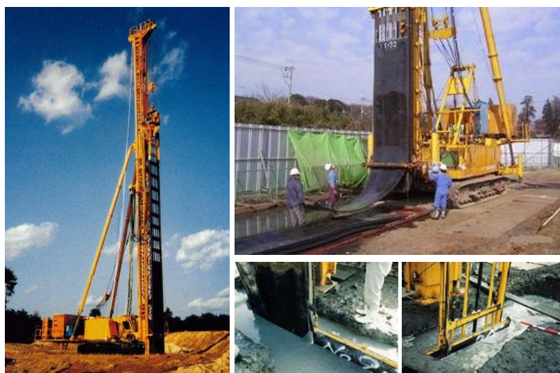
(a) 直接鉛直に遮水シートを設置する方法
