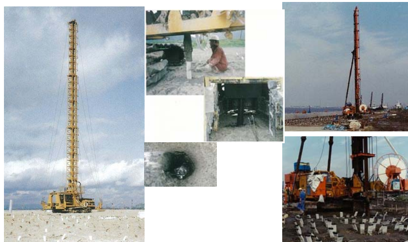
(a) 軟弱地盤対策のための圧密促進工（バッチカルドレーン工法）
