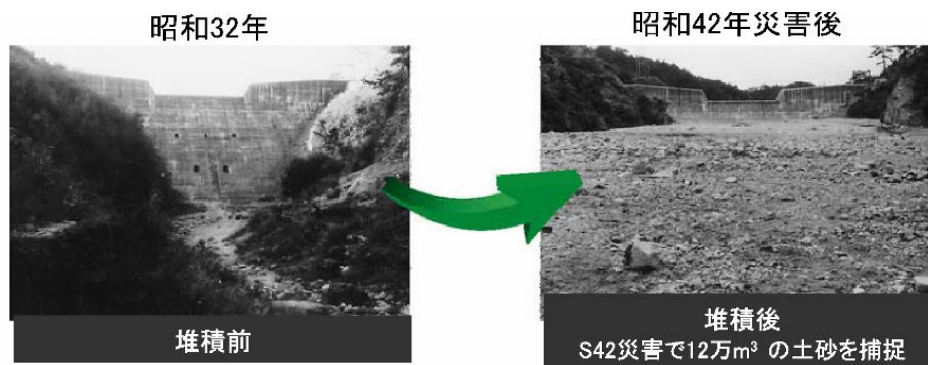
図ー2.5.3 五助堰堤の土砂捕捉状況 3)
