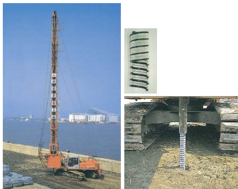
(b) 液状化対策工（静的圧入）
