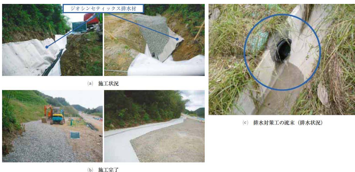
写真-4.1.8 兵庫県佐用郡のL型排水盛土防水工による排水対策事例
