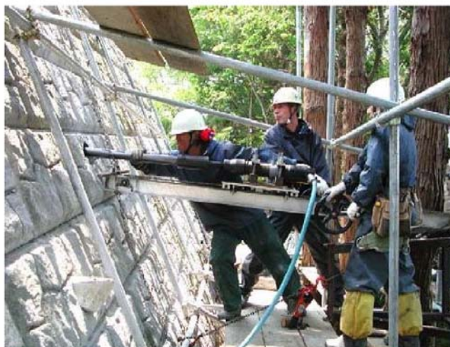
写真-2.3.1 排水補強パイプの施工状況 3)
