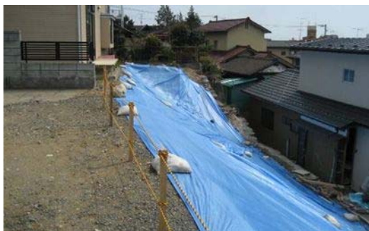
写真-2.2.1 B～B' 断面東側の崩壊状況 3)
