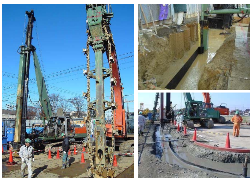
(b) 横引きによって遮水シートを設置する方法
