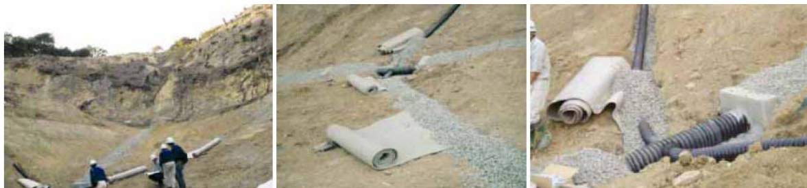
写真-4.1.7 兵庫県神戸市東灘区のL型排水盛土防水工による排水対策事例
