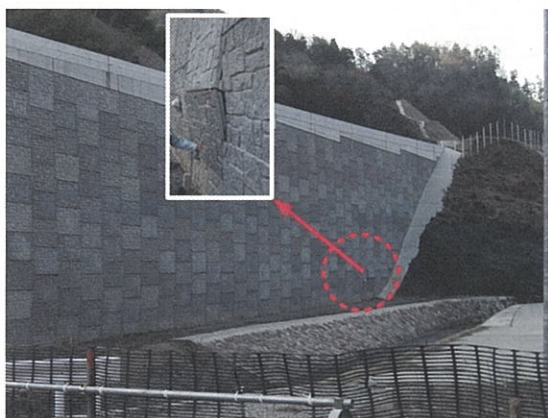
写真-3.3.2 補強土壁変状箇所 (測線 L2 の距離程 117m 付近)
