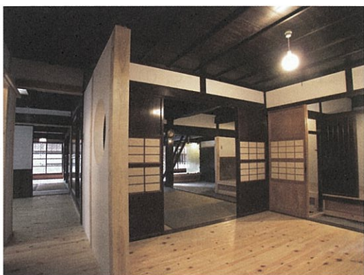
写真-3.3.17 K1邸（水平構面の新設）
