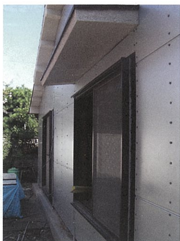
写真-3.3.26 Y邸（鋼板サンドイッチパネル・施工）
