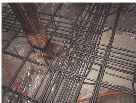
写真-3.3.19 K2邸（柱脚浮かし基礎施工）
