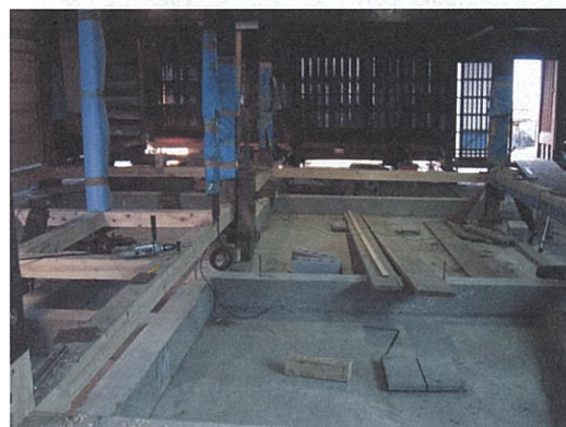
写真－3.3.14 K1邸（接合部：補強金物の設置）
