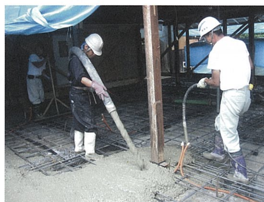
写真-3.3.22 K2邸（スラブ打設後の様子）
