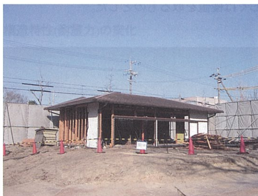
解体途中の試験体。雑壁と耐震壁の一部が撤去済みである。
