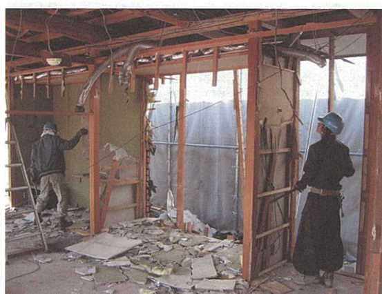
写真-7.2.6 耐震壁撤去の様子 (Case3)
