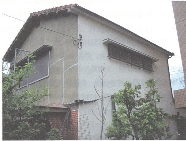
写真-2.4.1 ISH 邸の外観(兵庫県南部地震時に壁面に発生したクラック跡が確認できる)
