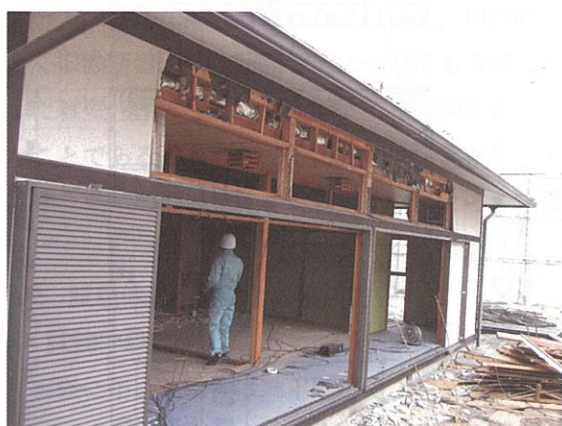
写真-7.2.5 雑壁撤去の様子 (Case2)
